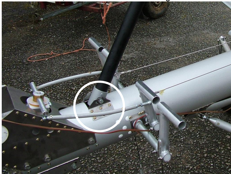
Abbildung 1: A-Säulenbefestigung an der Oberseite des Rumpfrohres. Untere Befestigungsschraube unter Hauptumpfrohr sichtbar und am hinteren Ende der Halterung am Bugradträger befestigt.
